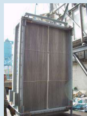
Fig.7-5 二重管式熱交換器
